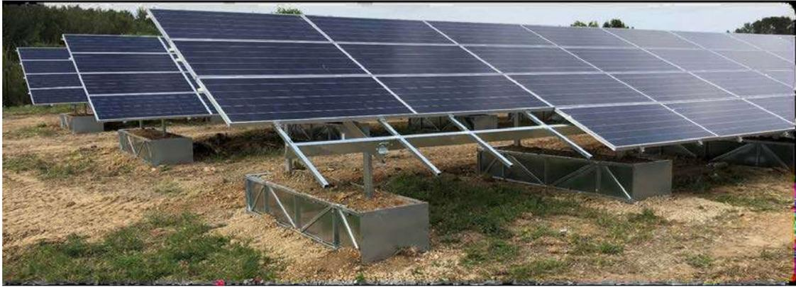
Figure 8: Exemple de structure de gabions
